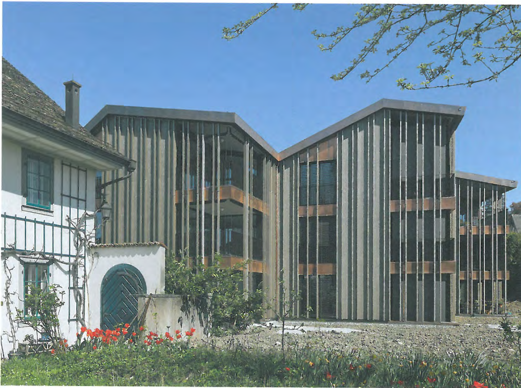
Ersatz, Ensemble, Nachverdichtung: Das neue Wohnhaus entwickelt sich aus dem Volumen der alten Scheune heraus und gesellt sich gleichwertig zum Herrenhaus.
